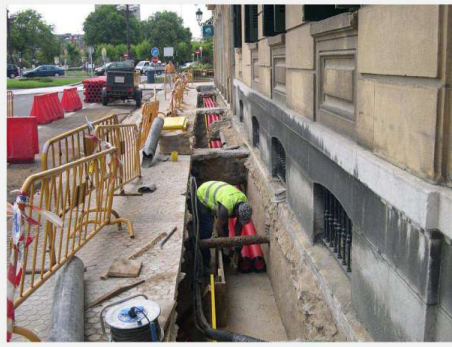
Tendido de canalizaciones
